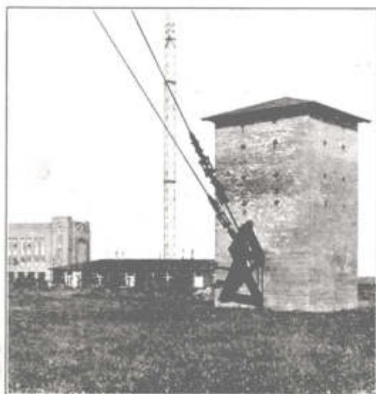
Bild 7. Abspannfundament mit Isolation.
