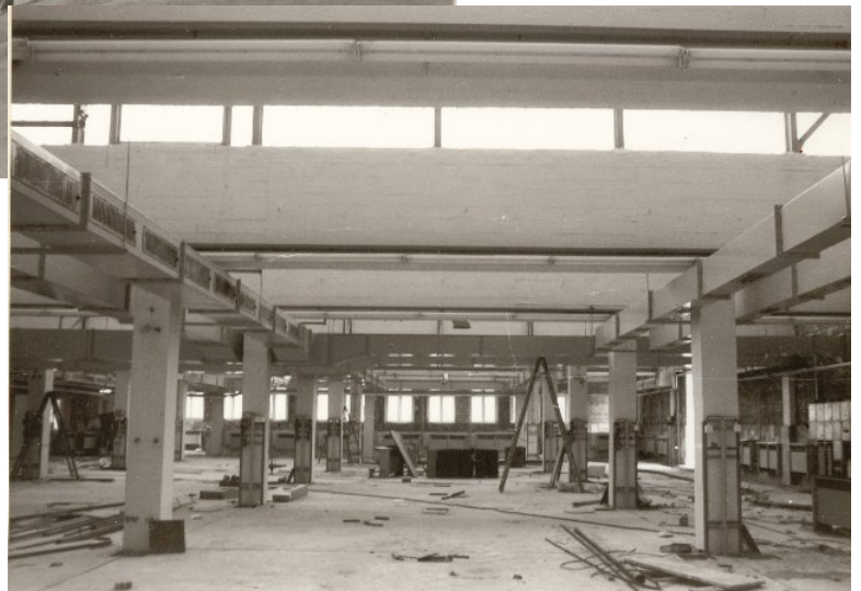
Neue Produktionshalle 880 m 2
