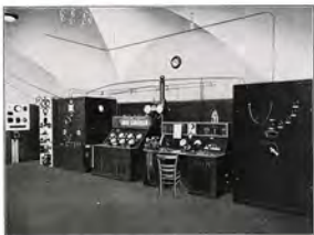
Bild 11. 10 kW Telefunken-Röhrensender im Senderhaus I.
