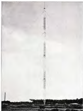
Bild 44. Gesamtansicht eines Mastes.
