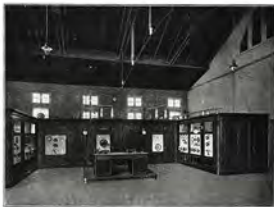
Bild 27. 20 kW Telefunken-Röhrensender im Senderhaus 2. (Vorderansicht).
