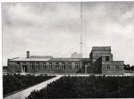
Bild 43. Seitenansicht des Sendergebäudes.
