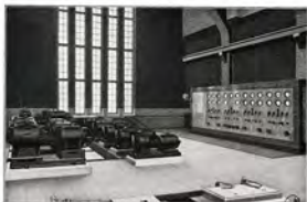
Bild 35. Uniformerraum des Senderhauses 3.
