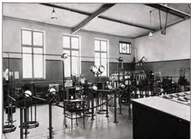
Bild 51. Teilansicht des Senderraums.
