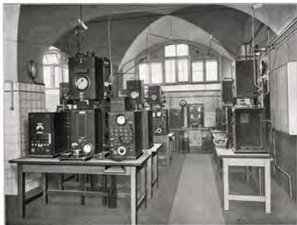
Bild 7. Senderraum mit 500/250 W Telefunken-Röhrensender im Senderhaus 1.
