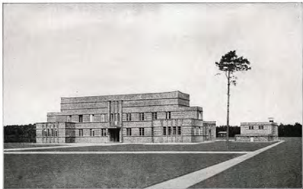
Bild 42. Gesamtansicht der Stationsgebäude.
