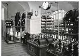
Bild 3. 70 kW Telefunken-Totfunksender.
