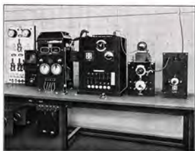
Bild 16. 500 W Telefunken-Röhrensender im Senderhaus I.
